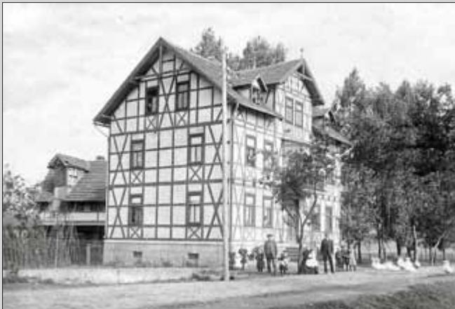
Die Gaststätte „Zur Erholung“ in Unterbreizbach
